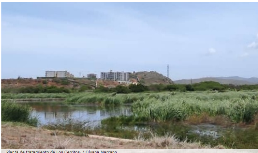
Planta de tratamiento de Los Cerritos. / Olyana Marcano
